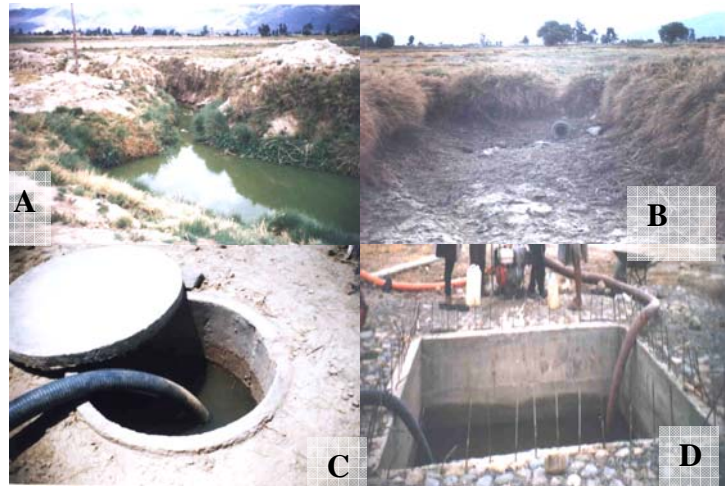
A y B Cámaras rústicas para la distribución de agua, comunidades de: Chirusi Grande y Tajamar Centro C Cámara de limpieza y riego D Cárcamo mejorado de hormigón ciclópeo
