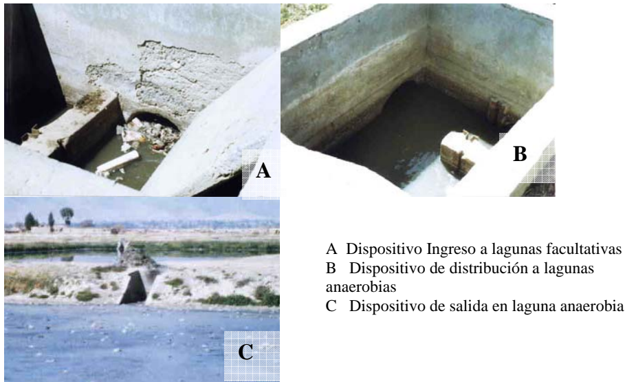
Figura N° 10: Dispositivos de ingreso, salida y distribución en las lagunas
