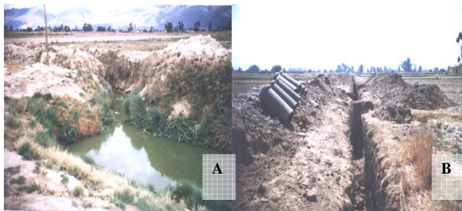
A Canal y cárcamo de tierra, Comunidad Chirusi Grande B Tubos dotados por el Gobierno Municipal de Punata para el mejoramiento del sistema de riego (comunidad Chirusi Grande)
