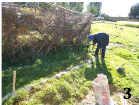
Marcado de la línea de excavación para tendido de tuberías (3 y 4)
