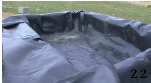
22. Tendido y acomodado de la geomembrana en el dique del humedal.
