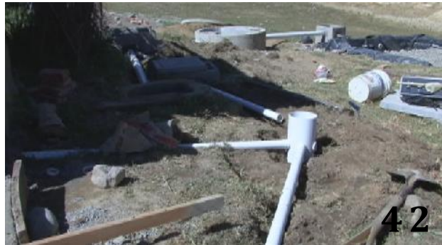
42. Panorámica general del tendido de tuberías y conexiones de la PTAR familiar.
