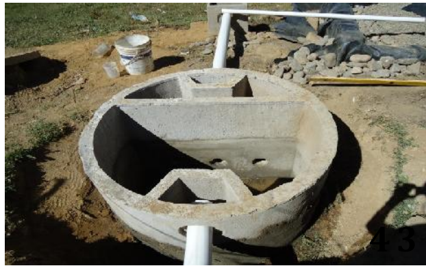
43. Conexión de tuberías entre la cámara de aguas grises, biofosa y humedal.
