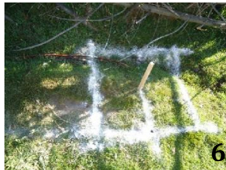
Marcado de la ubicación de la biofosa (5) y cámara de inspección (6) para su posterior excavación
