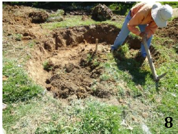
8. Excavación para la instalación de la biofosa.
