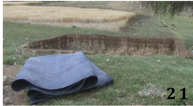
21. Geomembrana a emplearse en la impermeabilizacion del dique del humedal.
