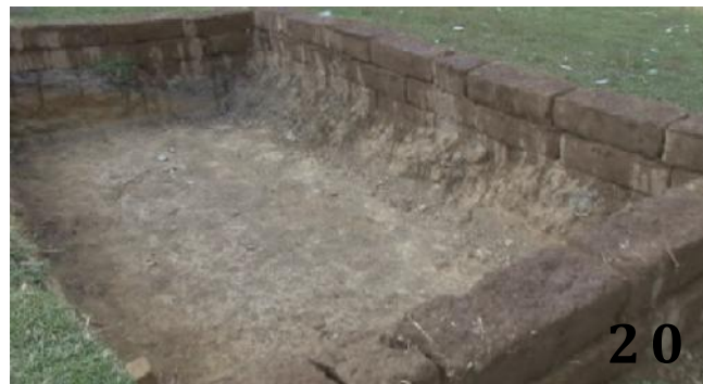
20. Dique del humedal construido y listo para ser impermeabilizado.
