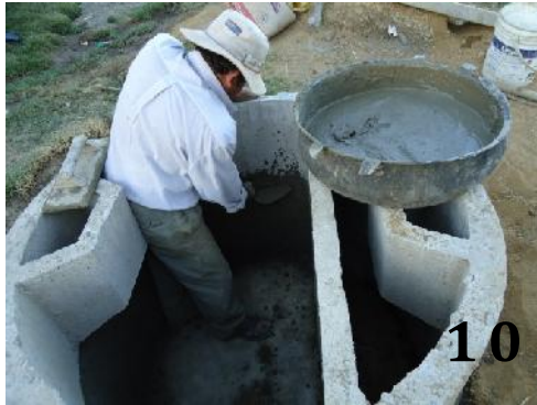
Instalación de la biofosa (10) y de la cámara de ingreso a la biofosa (11)
