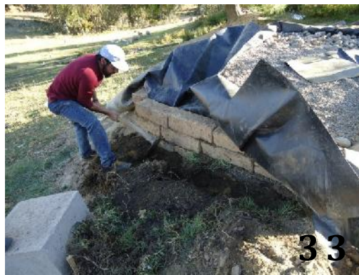
33. Excavación de la zanja de anclaje del humedal.
