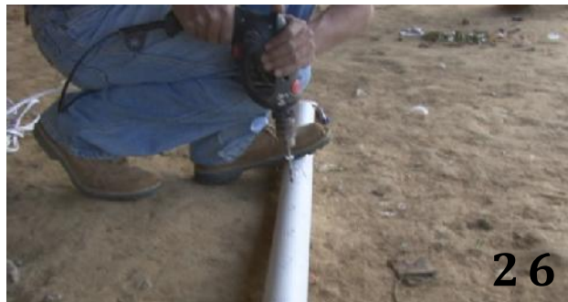
26. Perforacion de la tuberia de drenaje del humedal.
