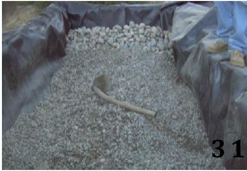
31. Esparcido de grava en el humedal. 32. Humedal lleno de grava, nivelado.
