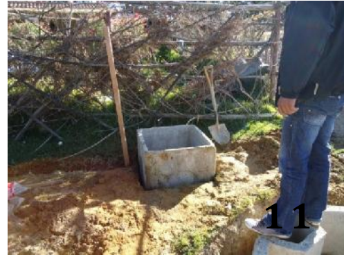
Instalación de la biofosa (10) y de la cámara de ingreso a la biofosa (11)
