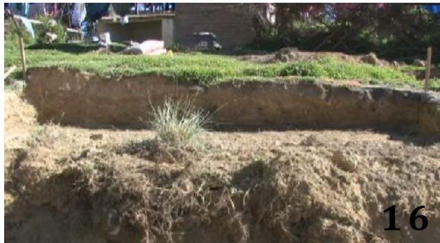
16. Excavación del dique del humedal.
