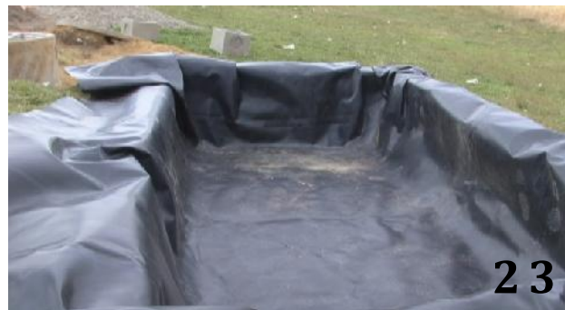
23. Dique del humedal impermeabilizado.
