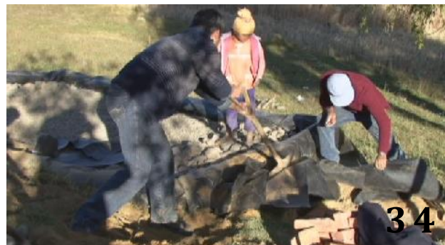
34. Anclado de la geomembrana con tierra.
