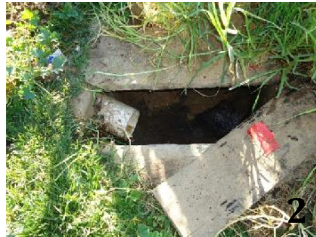
Identificación de los puntos de vertido de aguas grises (1) y aguas negras (2)
