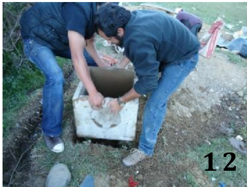
Instalación de cámara de aguas grises (12 y 13)
