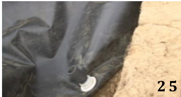
25. Brida instalada en la geomembrana para la instalacion del drenaje del humedal
