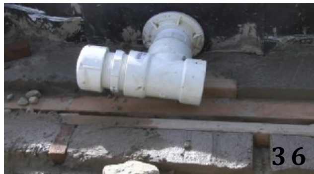
36. Construcción del sistema de aplicación de agua residual al humedal.
