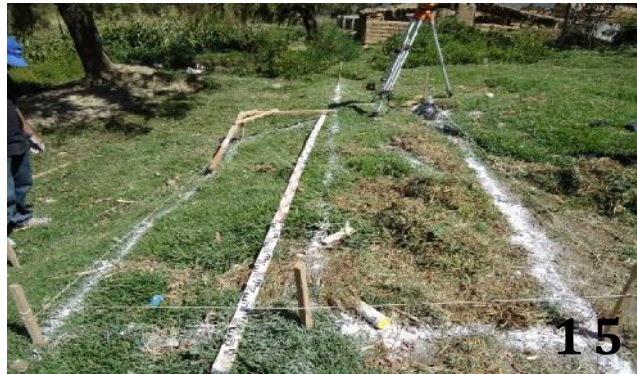
15. Marcado del lugar de implementación del humedal
