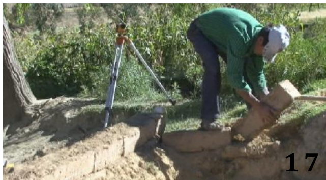
17 y 18. Construcción del muro inferior del dique del humedal
