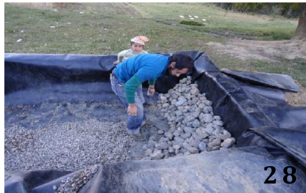
28. Colocado de piedra de drenaje del humedal.
