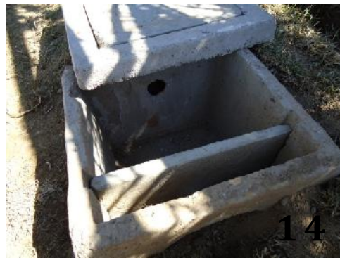
Trampa de grasa y aceites prefabricada instalada (14)
