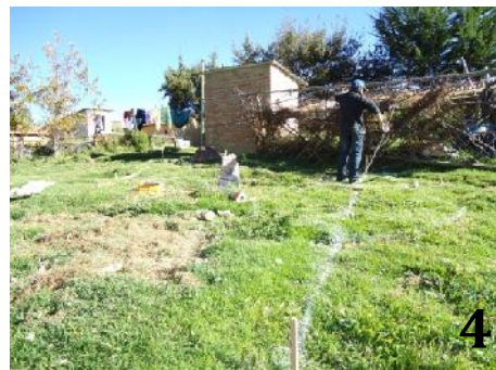
Marcado de la línea de excavación para tendido de tuberías (3 y 4)
