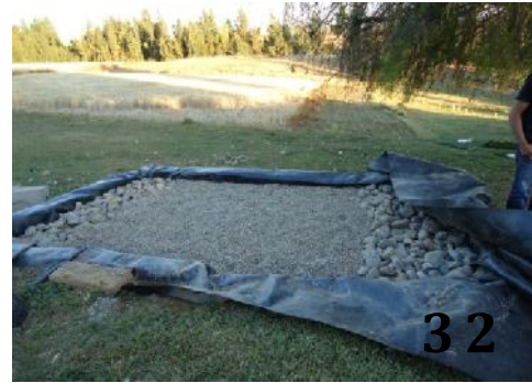
31. Esparcido de grava en el humedal. 32. Humedal lleno de grava, nivelado.
