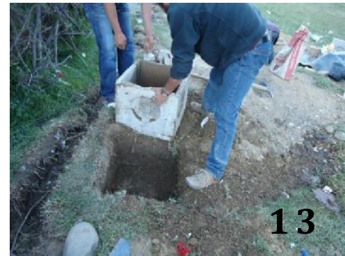
Instalación de cámara de aguas grises (12 y 13)
