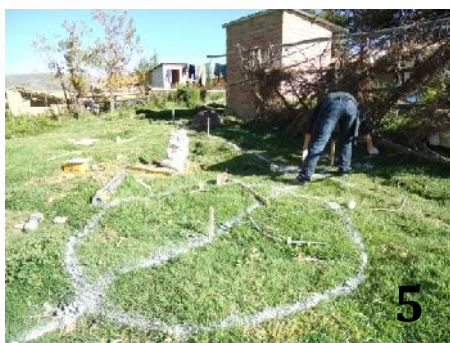
Marcado de la ubicación de la biofosa (5) y cámara de inspección (6) para su posterior excavación
