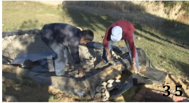
35. Colocado de piedra para el anclaje de la geomembrana.
