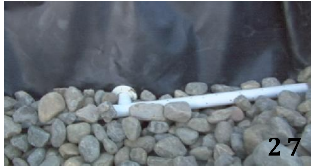
27. Tuberia de drenaje instalada
