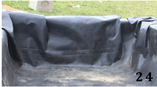
24. Detalle del doblado de la geomembrana en los vertices del dique del humedal.
