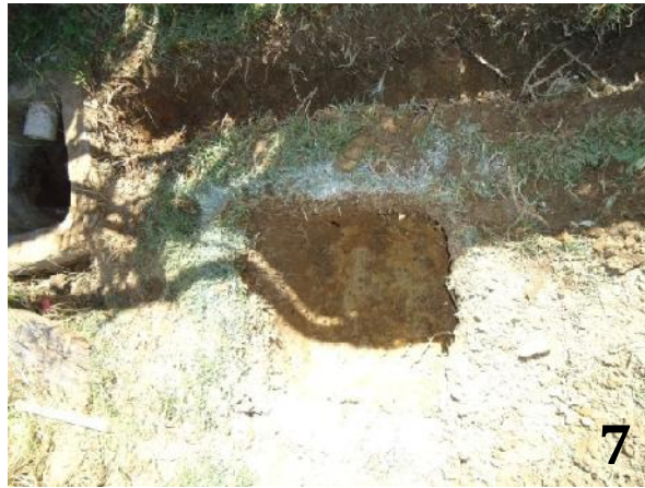
7. Excavación para la instalación de la trampa de grasas.
