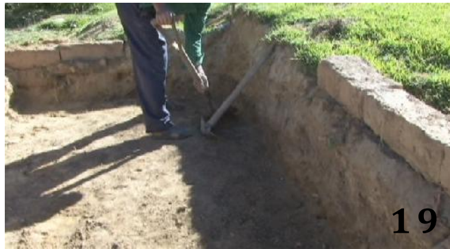
19. Nivelado de la base e igualado de los muros del dique del humedal.
