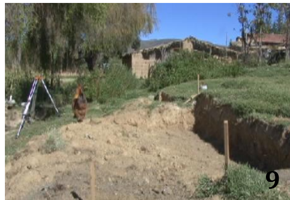
9. Excavación para la construcción del humedal artificial de flujo subsuperficial horizontal.
