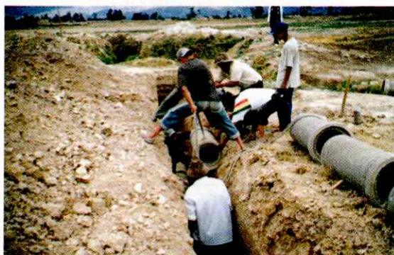
Figura 10: Mejoramiento de sistema de riego: Colocado de tubos
