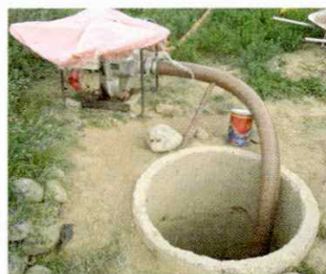
A) Cámara de limpieza
