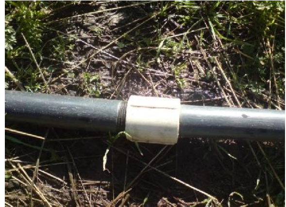
Fig. 26 Acople de plástico en matriz principal.
