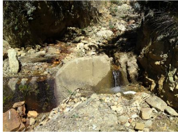
Fig. 17 Segunda toma en tubería.
