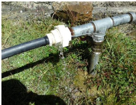
Fig. 23 Matriz principal conectado al hidrante.
