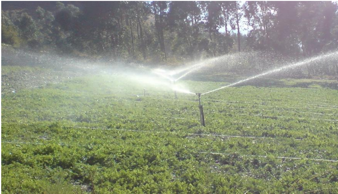
Fig. 24 Matriz secundaria de distribución en funcionamiento.
